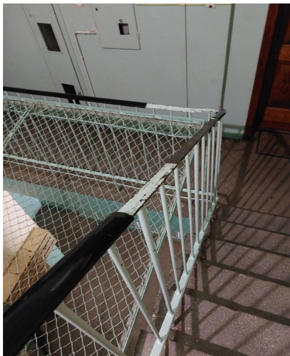
Fot. 8. Przerwana ciągłość okładzin poręczy.
